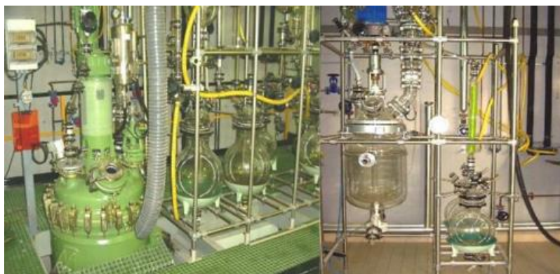
Instalaciones de la planta piloto
