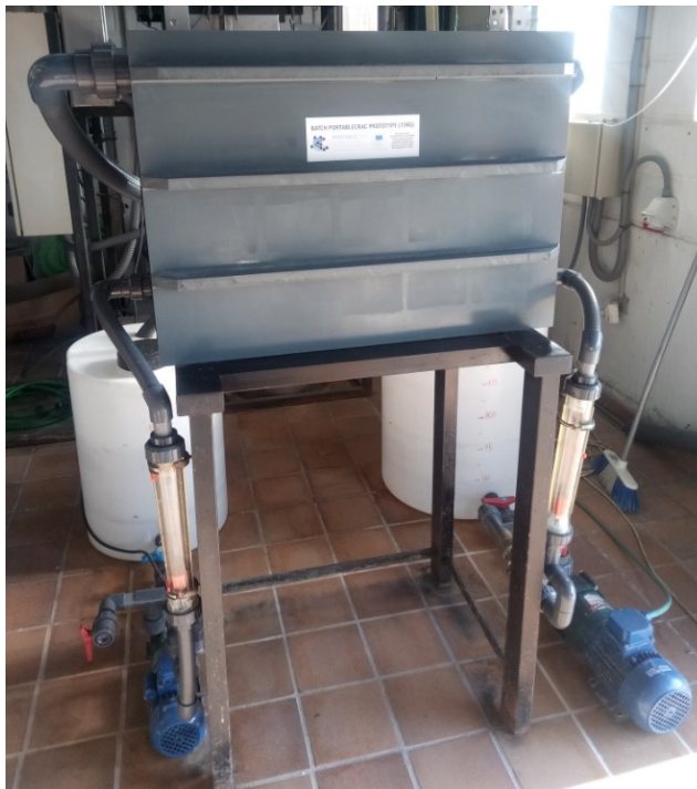
Fotografía 1: vista frontal del reactor electroquímico en la configuración de electrodos planos paralelos con una capacidad de tratamiento de 15kg.
