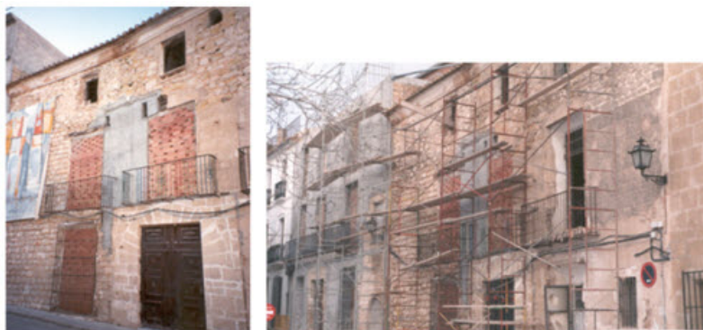
Estado de los edificios previo al proceso de intervención.
