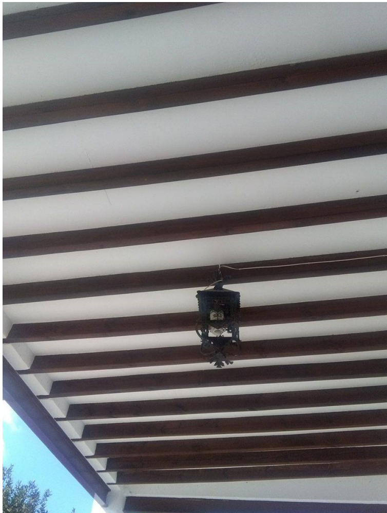
Figura 8.c. Rehabilitación terminada, vista inferior.
