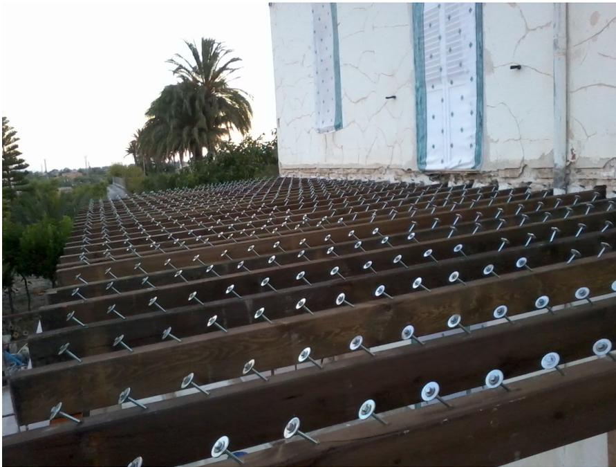
*Figura 8.a. Rehabilitación. Vigas con conectores.*
