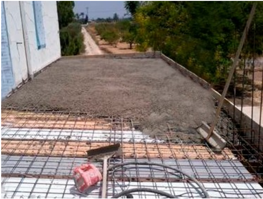
Figura 8.b. Rehabilitación. Hormigonado del forjado.
