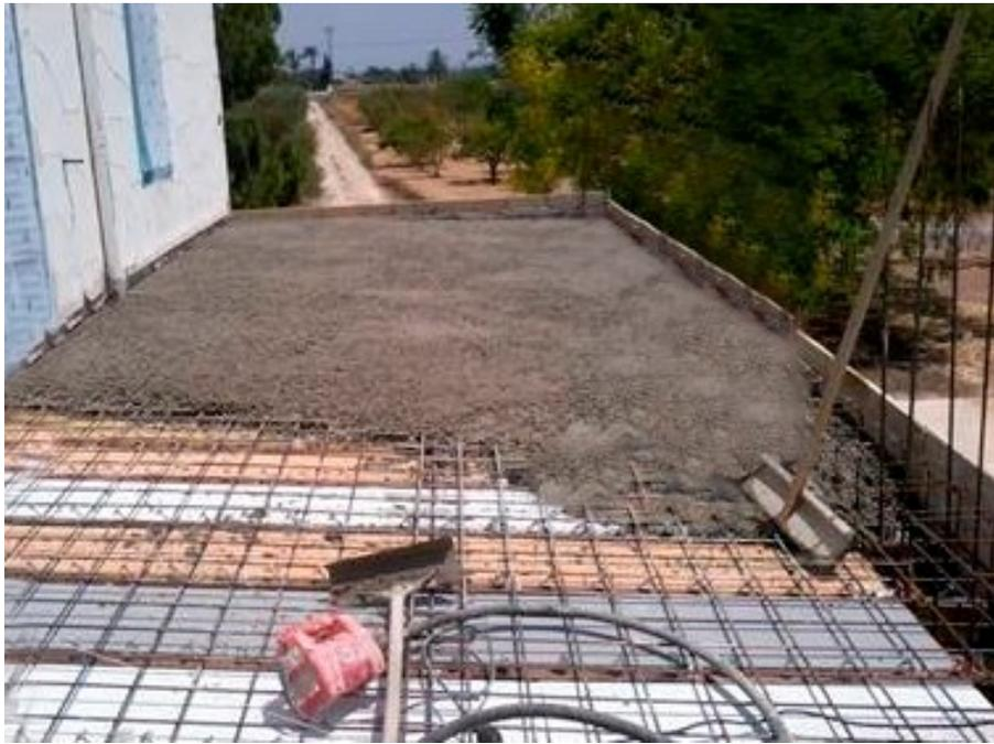
*Figura 8.b. Rehabilitación. Hormigonado del forjado.*
