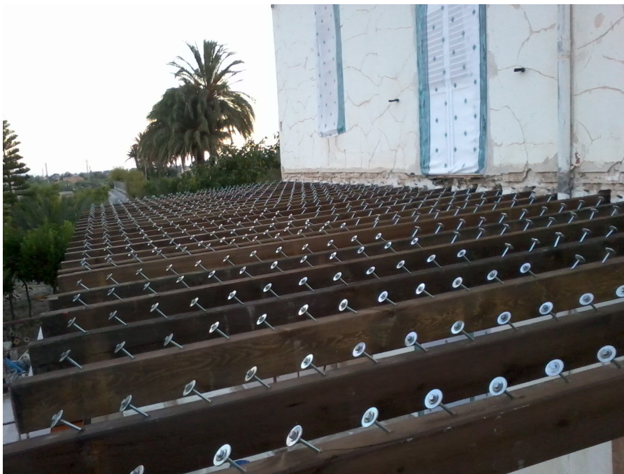
Figura 8.a. Rehabilitación. Vigas con conectores.
