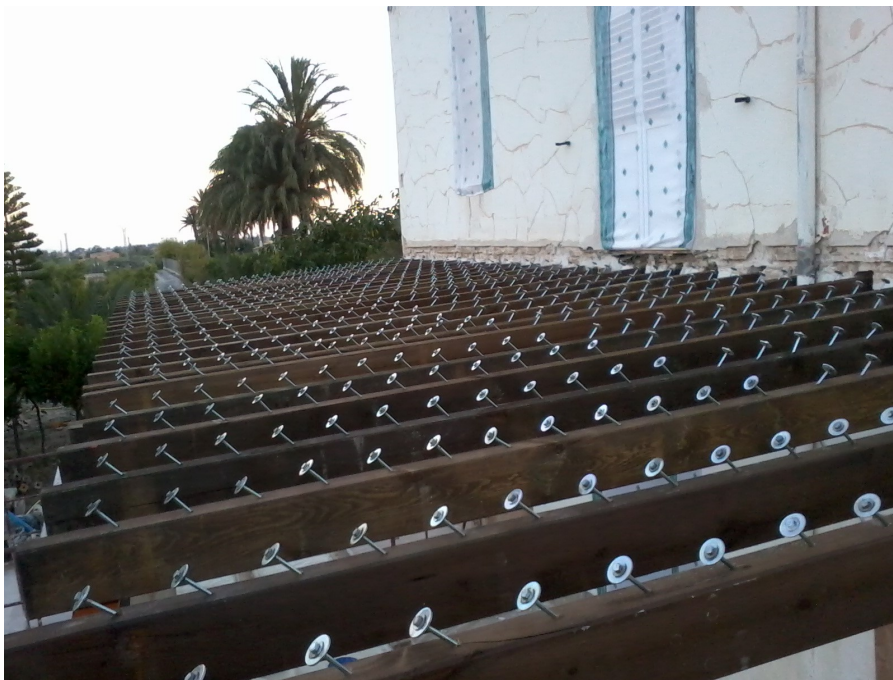
Figura 8.a. Rehabilitación. Vigas con conectores.
