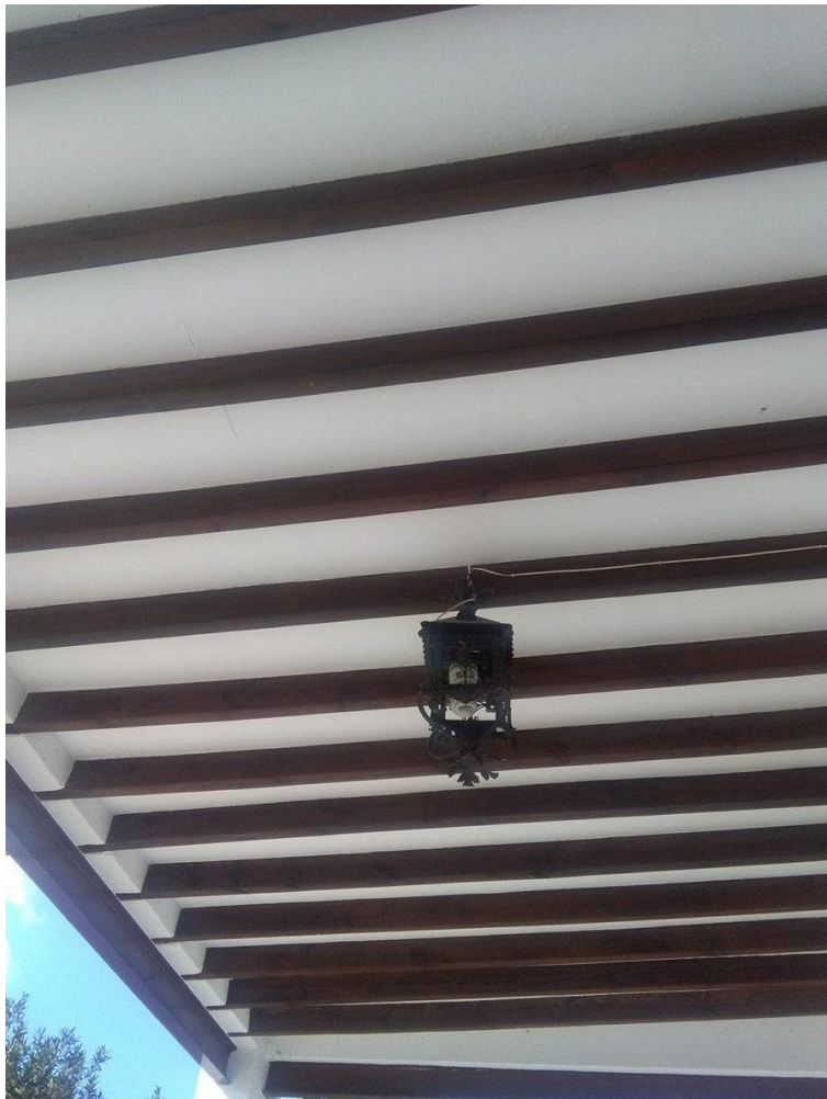
Figura 8.c. Rehabilitación terminada, vista inferior.
