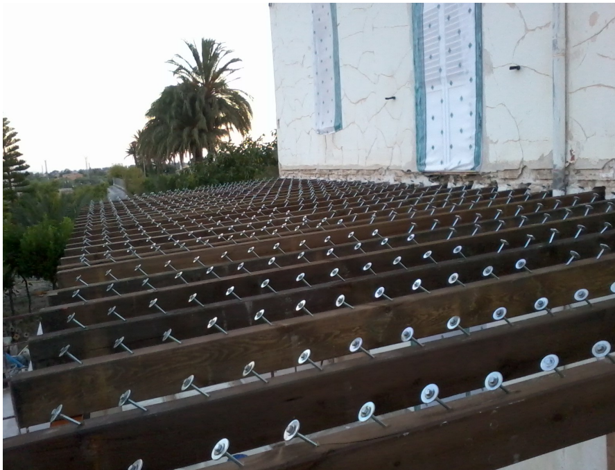
Figura 8.a. Rehabilitación. Vigas con conectores.
