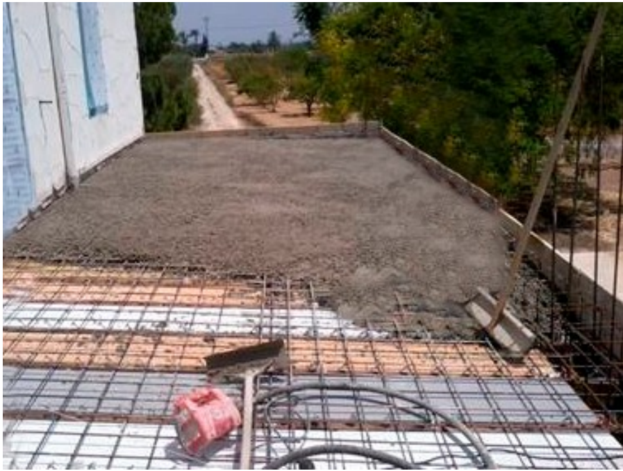
Figura 8.b. Rehabilitación. Hormigonado del forjado.
