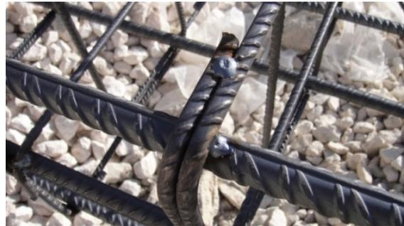
El montaje de estas armaduras, realizado en el taller de ferralla o en la propia obra, requiere una dedicación de tiempo importante. Además es necesario contar con mano de obra especializada y sistemas auxiliares para unir los diferentes elementos como tenazas o pistolas de atado.
