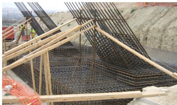
Para la construcción de estos elementos, un aspecto fundamental es la configuración de la armadura, que suele estar formada por barras o elementos metálicos unidos mediante atado con alambre o soldadura. Es importante que estos elementos se mantengan fijos y en la posición correcta durante el hormigonado para garantizar unas buenas propiedades estructurales durante la vida útil del elemento constructivo.
