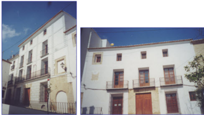
Estado de los edificios tras el proceso de restauración arquitectónica.
