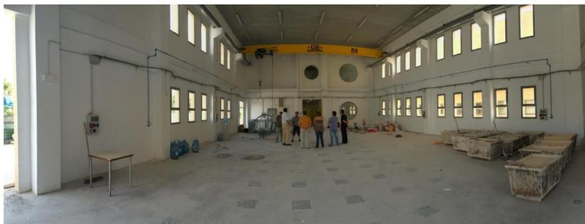
Una de las peculiaridades del edificio, diseñado específicamente para albergar laboratorios de investigación, es que cuenta con una losa maciza de hormigón sobre la que se pueden realizar pruebas de resistencia de estructuras de acero y hormigón, principalmente.
