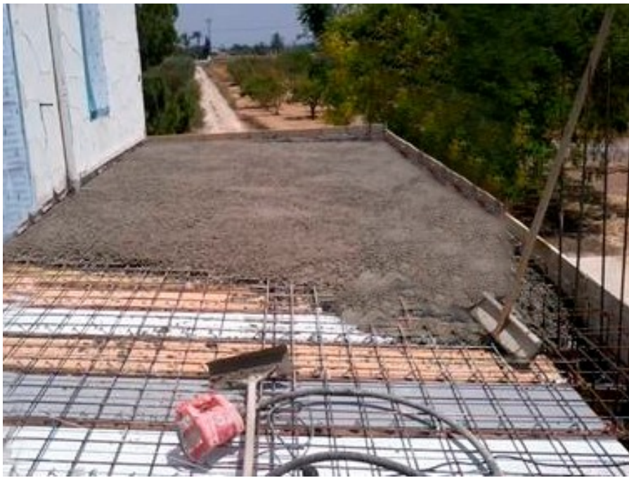
Figura 8.b. Rehabilitación. Hormigonado del forjado.
