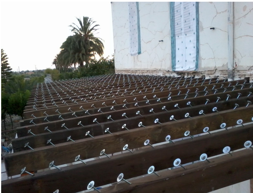
Figura 8.a. Rehabilitación. Vigas con conectores.
