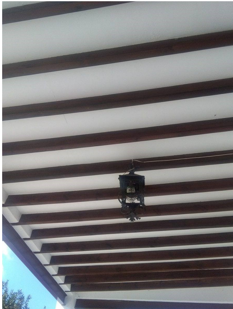
Figura 8.c. Rehabilitación terminada, vista inferior.
